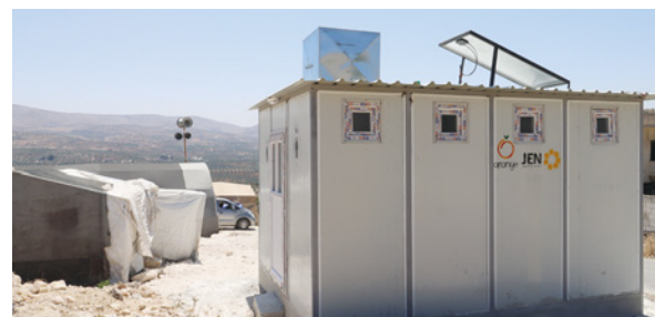
シリアで設置したトイレ Pictured are toilets installed in Syria
