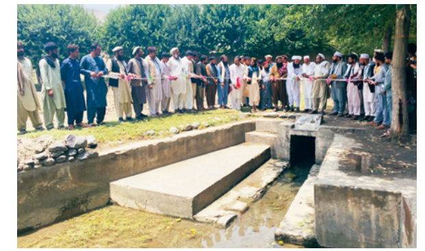
完成した灌漑用水路整備 Completed construction of irrigation canal
